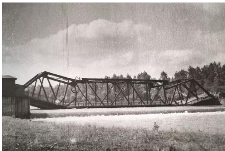
▲ Poškozený vratimovský most po průchodu výhlední fronty 1. května 1945 (Archiv města Ostravy)
